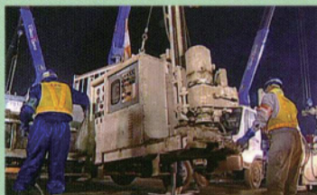
マーキング位置にボーリングマシンをセット
