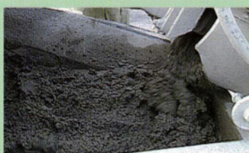
能率的な連続ミキサーによるモルタル供給
