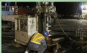
削孔スライムもすべて回収
